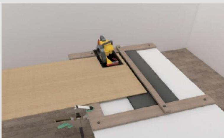
1- Utilizar a serra circular elétrica para cortar o painel de parede de acordo com os tamanhos pretendido.
