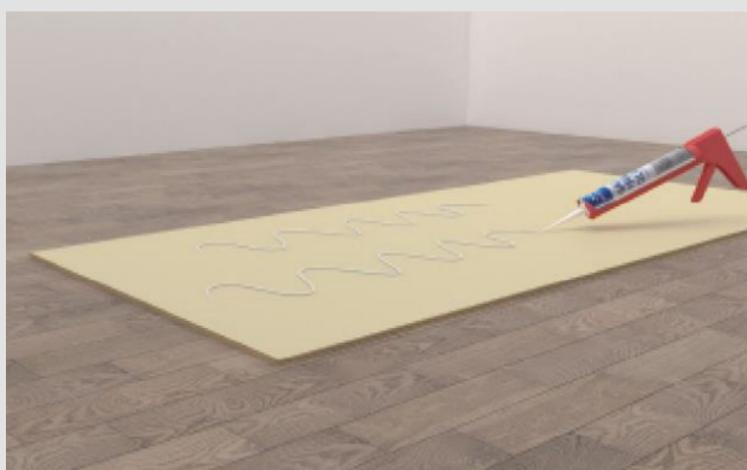
2- Colocar Ultra Adesivo sem pregos na parte de trás do painel de parede;
