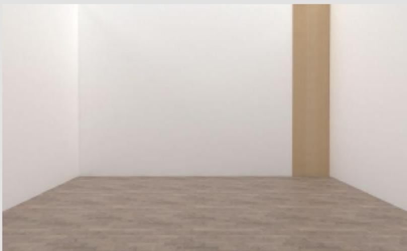
3. Colocar o painel na parede lisa e bater ligeiramente para aderir á parede;
